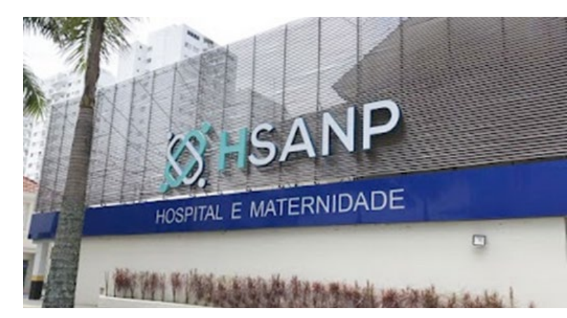
HOSPITAL E MATERNIDADE HSANP INSTALAÇÃO DA CENTRAL DE ÁGUA GELADA Capacidade da obra: 420 TR
