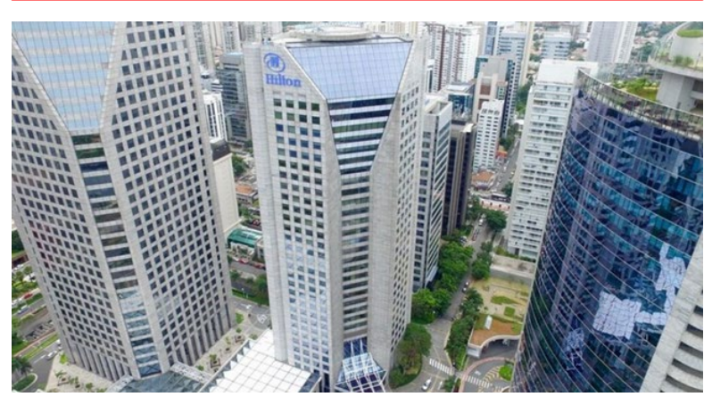
HOTEL HILTON – SP RETROFIT NA CENTRAL DE ÁGUA GELADA Capacidade total da obra: 1.050 TR Certificação LEED GOLD
