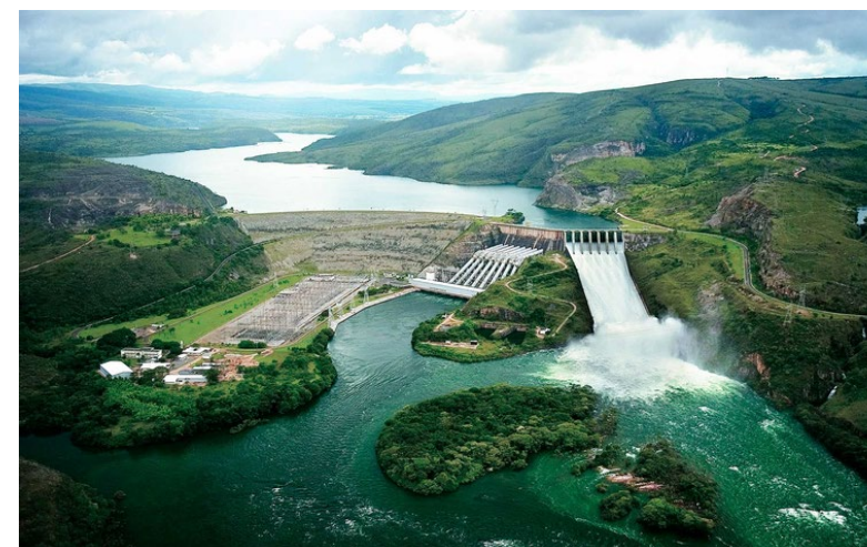
Usina Hidrelétrica de Xingó – Alagoas
