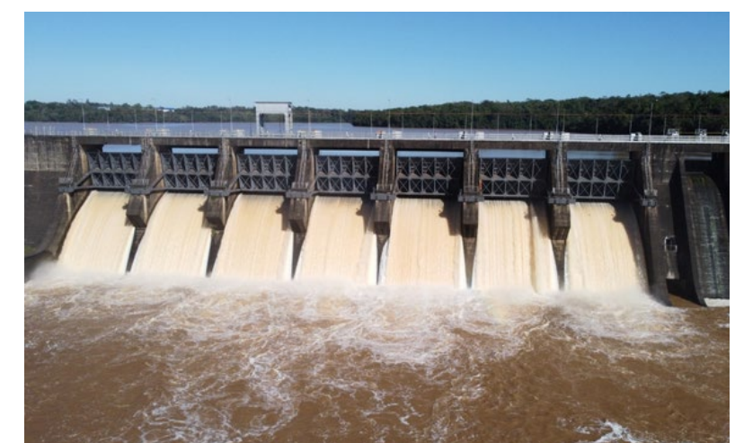
Usina Hidrelétrica de Acaray - Paraguai
